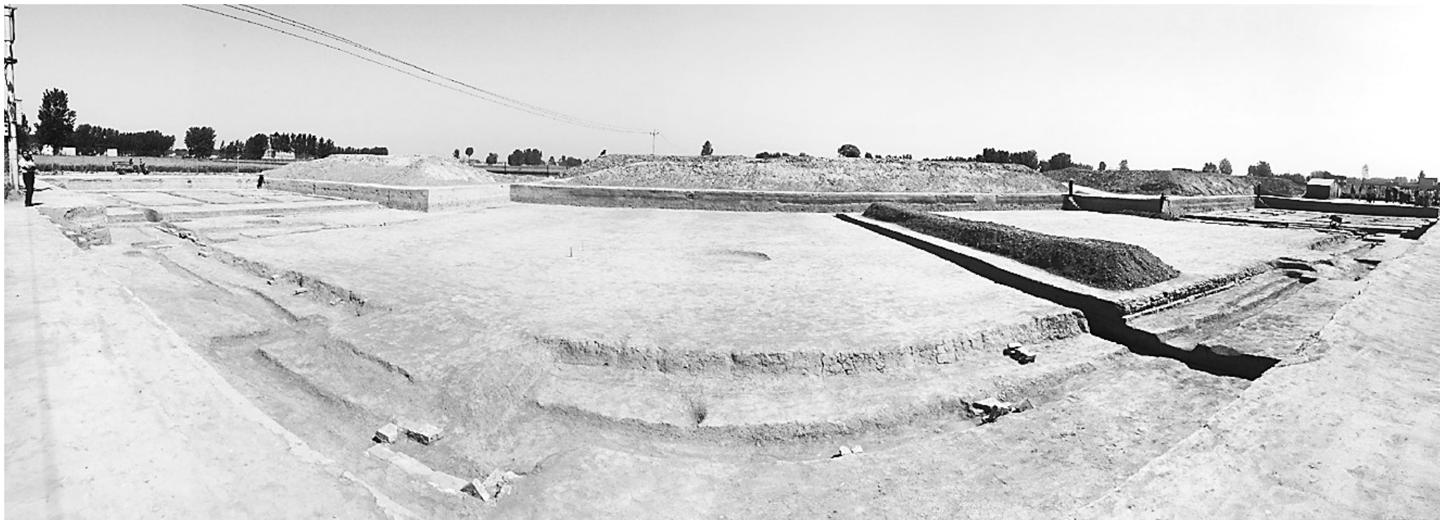
核桃园1号塔基挖掘现场。陈正摄
