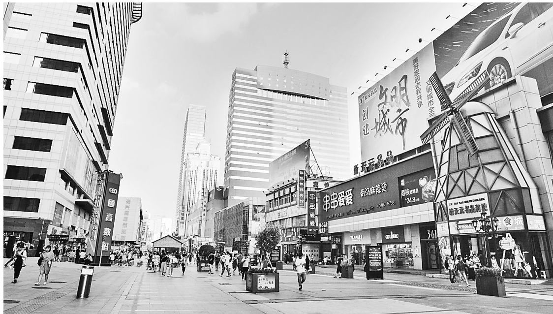
近日,石家庄市民族路商业步行街升级改造一期工程完工。经过路面修缮、路灯安装、沿街建筑整治等工作,民族路商业步行街形象大幅提升。下一步,还将对民族路商业步行街周边景观、业态进行调整升级。 武頔 张震摄
