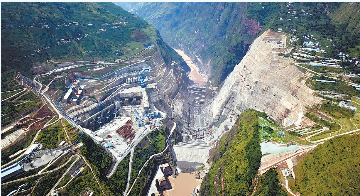
这是7月27日航拍的白鹤滩水电站建设工地。8月3日,全球在建装机规模最大的水电站白鹤滩水电站进入主体工程全面建设阶段。白鹤滩水电站位于四川省宁南县和云南省巧家县境内的金沙江干流下游河段上,总装机容量达1600万千瓦,是仅次于三峡工程的世界第二大水电站。该工程由中国三峡集团承建,是国家能源战略布局“西电东送”的骨干电源点。新华社发
