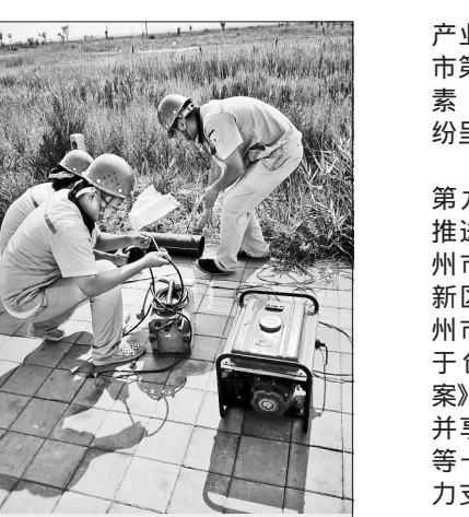
日前,中捷城管局联合园区燃气经营企业,组织开展了主题为“警钟长鸣”全面落实企业安全生产主体责任管道天然气泄漏应急演练活动。图为演练现场。 记者 戴绍志摄
