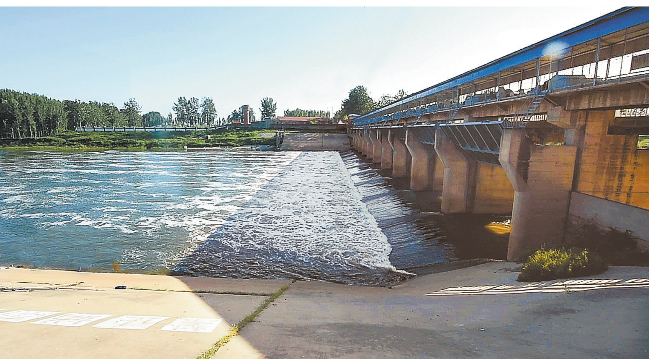
青龙湾减河土门楼泄洪闸。 记者 田瑞夫摄
