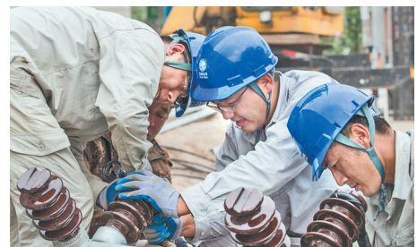
10月底前，廊坊将完成全市72.9万户农村群众的散煤替代。图为三河市电代煤施工现场。
