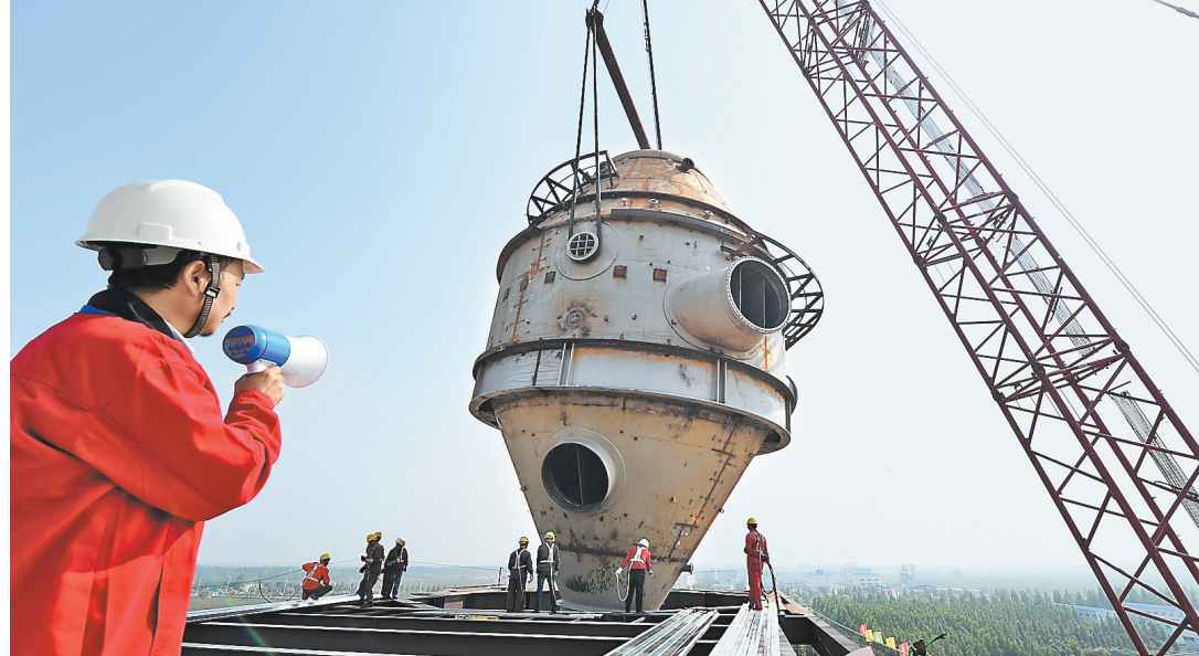
9月21日,位于宁晋县的河北中盐龙祥盐业有限公司重达234吨的制盐核心设备蒸发结晶器成功吊装。中盐龙祥是央企入冀重点企业,预计2018年6月建成投产,将采用世界上最先进的机械压缩蒸发制盐工艺,生产全程实现零排放。 记者 赵永辉摄
