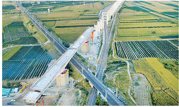
京张高铁跨怀来县大秦铁路土木特大桥吊装合龙。 孙慧军摄
