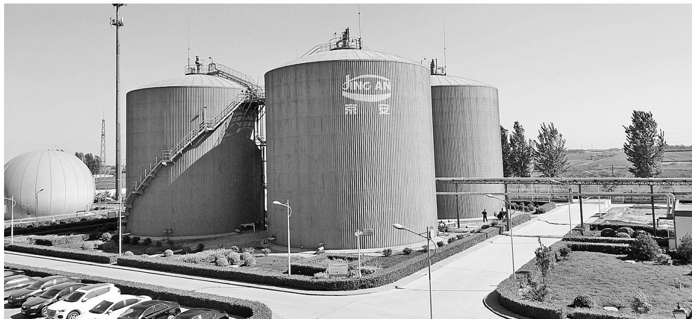
京安现代农业园区内的5000立方米CSTR中温全混厌氧发酵系统。
