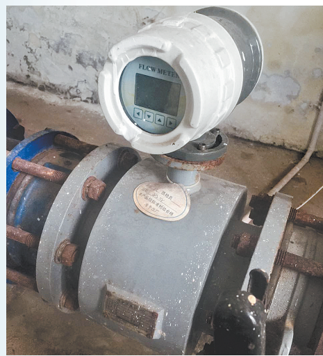
魏县李照河村坑塘灌溉工程取水处使用电磁流量计对取水量进行监控。 记者 袁伟华摄
