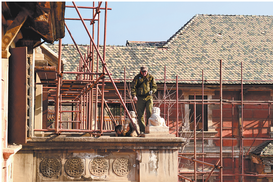
宝蕴楼修缮现场。
