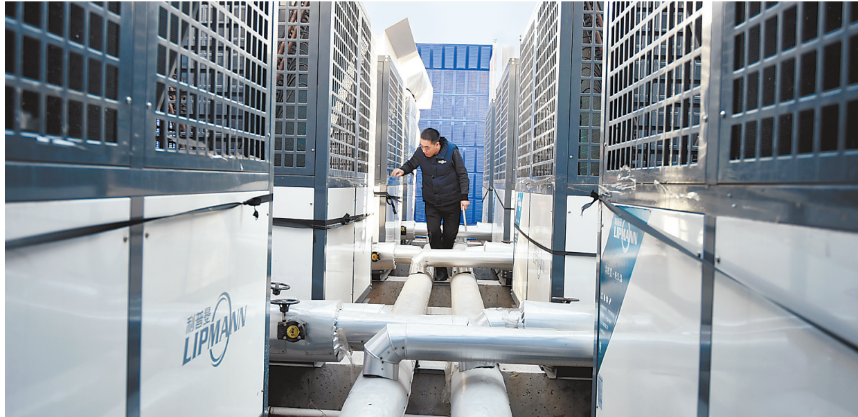
11月20日,在秦皇岛深河中学,工人正在对已经投入使用的新能源取暖设备进行维护。今年以来,秦皇岛经济技术开发区投入900多万元,在13所农村中小学及办学点推广应用新能源取暖设备,用空气源热泵技术替代传统的燃煤、燃油取暖。空气源热泵技术以极少的电能,吸收空气中的低温热能,压缩转化成高温热能,具有能耗低、效率高、环保性强等特点。
