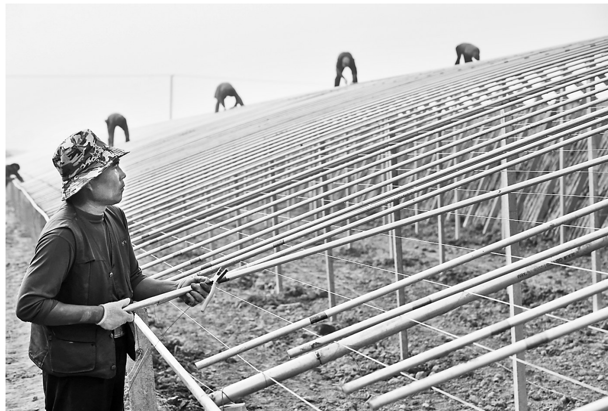
近日,施工人员在泊头市营子乡郝楼村京菜园进行冬暖式日光温室安装作业。泊头市营子乡郝楼村大部分村民在北京或务工、或做建筑扣件租赁生意...
