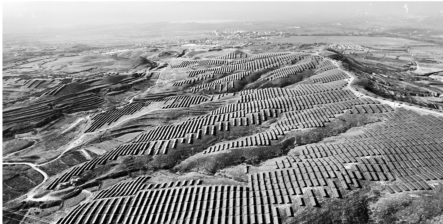
近年来,下花园区依托丰富的太阳能资源和独特的区位优势,在京藏高速下花园段两侧实施了5个奥运迎宾光伏廊道项目,总投资37.7亿元,总装机规模38.5万千瓦,并获得19.5万千瓦并网指标。这是下花园区辛庄子乡张家庄村荒山上建设的光伏项目。梁清 尹辉摄
