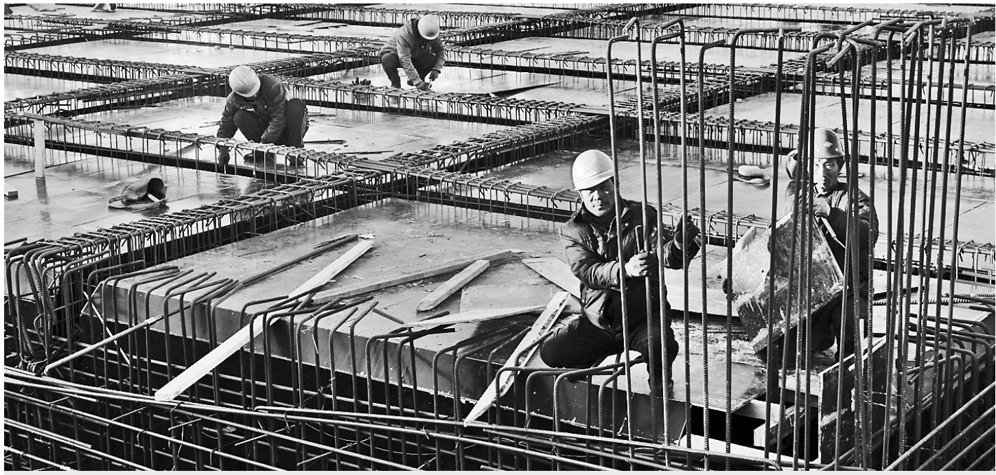
日前,在河北理工大学迁安学院1号蓄水池工地,工人们正在紧张施工。在海绵城市建设过程中,迁安市严把质量关、安全关,确保工程质量。 陈 儒摄
