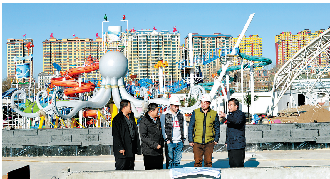
12月5日,在正定县塔元庄村已经雏形初现的大型水上乐园项目建设现场,十九大代表、塔元庄村党支部书记尹计平(右一),正和大家一起商议施工事项。记者 田明摄
