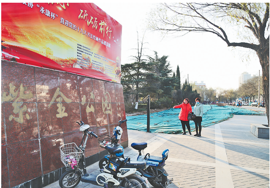
邢台紫金公园南侧二层违建已拆除,透出公园的绿意。
