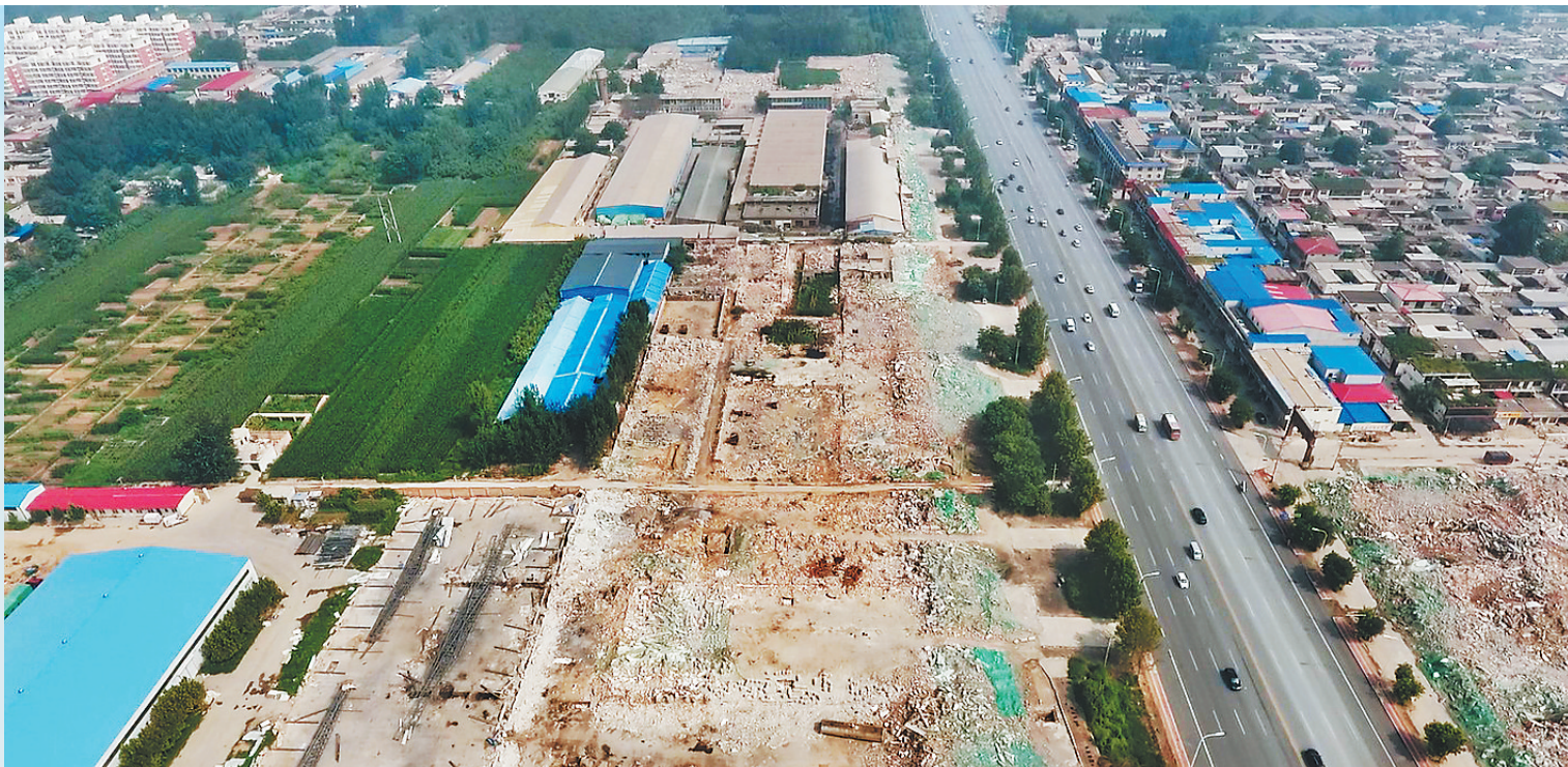
邢台祥和大街与东华路交叉口西北角拆后航拍图。 邢台市城管局供图
