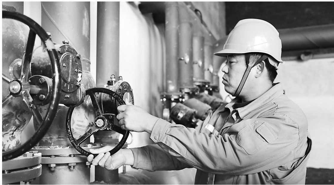
近日,沧州热力有限公司运东分区工作人员在调整二次网供水阀门。该公司是沧州市主要的集中供热单位之一,面对今年供热面积增加至2000万平方米的情况,他们努力践行“辛苦我一人,温暖千万家”的承诺,在保证安全稳定供暖的前提下,强化员工服务意识,提高服务质量,力争以实际行动赢得用户的满意。记者 王雅楠摄
