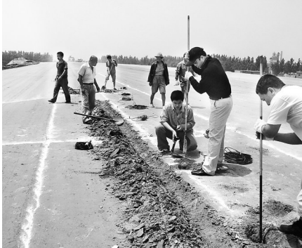
图为科研人员现场布线。
