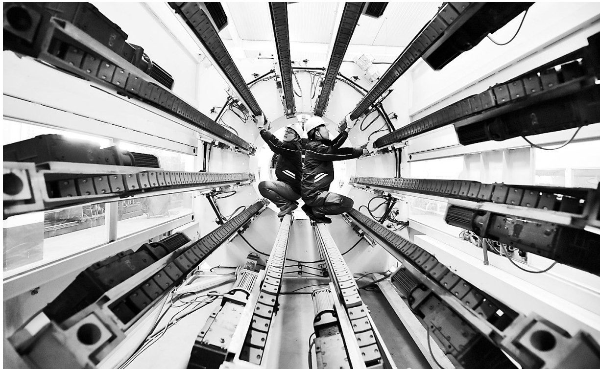
坐落于廊坊高新区的河北泉恩高科技管业有限公司引进世界先进生产技术和智能生产线,生产大口徑环保PVC、PE等新型环保管材,是国内唯一一家可以生产1.6米口径管材的企业,填补了中国超大口徑管材生产领域的空白。这是日前该公司员工在智能生产线上工作的情景。 庞博 张建辉摄
