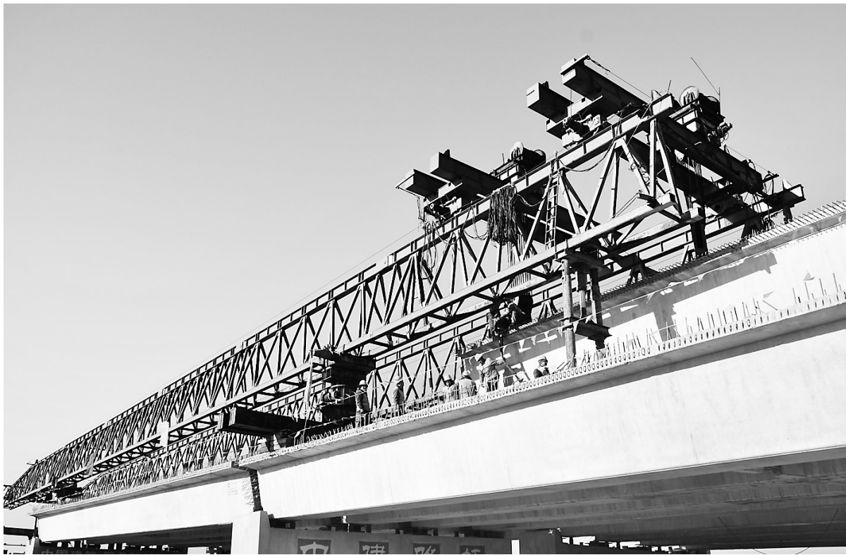
日前,中建路桥项目工地上呈现出一派热火朝天的景象,施工人员在忙碌地架桥。渤海新区黄骅港河口疏港二路段(通港路)工程是沧州市政府重点民生工程,也是渤海新区建设中首例采用悬浇施工技术的工程。该项目建成后,将成为沧州渤海新区疏港路与海防路的连接线,可有效改善交通环境,缓解交通压力。张诗启摄
