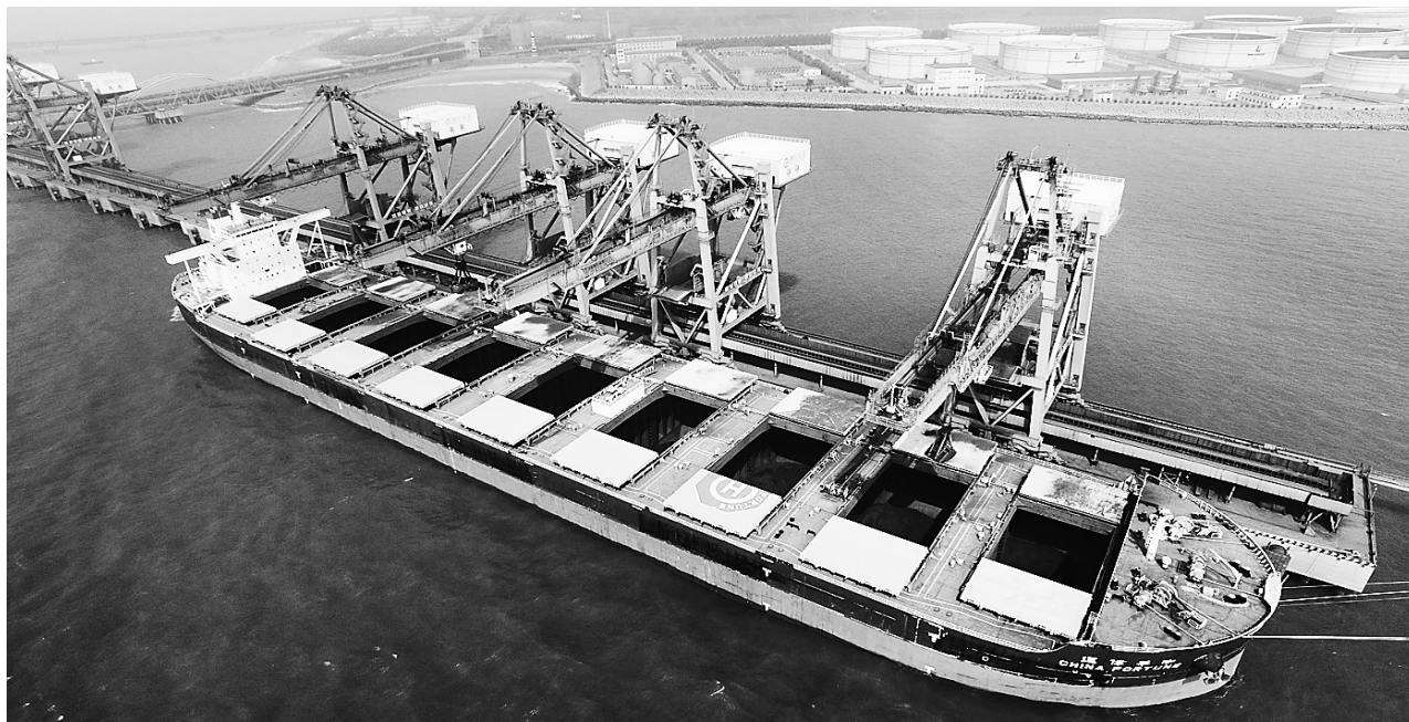
日前,在曹妃甸港区矿石码头,40万吨货轮正在进行卸船作业。
