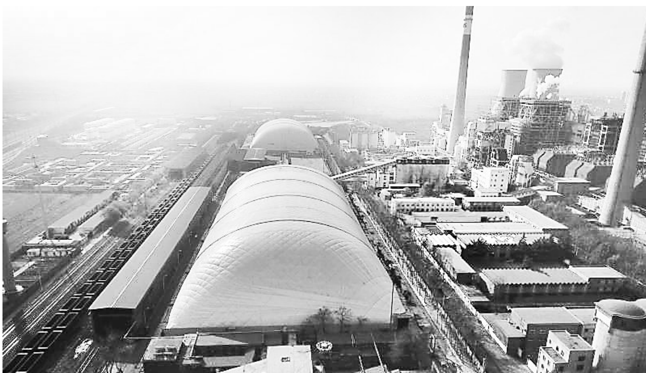
日前,邢台国泰发电有限责任公司投资7200多万元建成气膜全封闭煤场并投入使用。该设施作业面积3.7万多平方米,有效解决了煤场扬尘污染问题。图为航拍的气膜全封闭煤场。李红欣 黄涛摄
