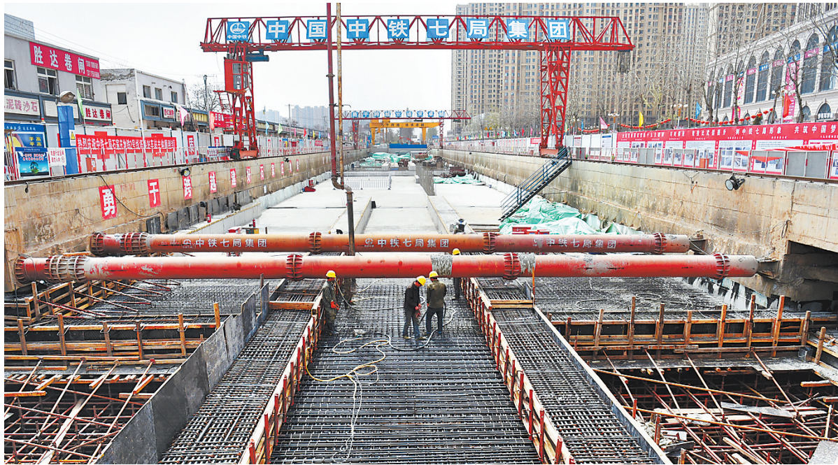
3月27日,石家庄地铁2号线塔谈站车站主体最后一块顶板浇筑完成,实现主体结构封顶。据了解,石家庄市轨道交通2号线一期工程线路长度16.2公里,截至目前,东岗头站、铁道大学站、塔谈站已实现封顶,一期工程车站完成主体工程的56%,区间完成工程量的18%。
