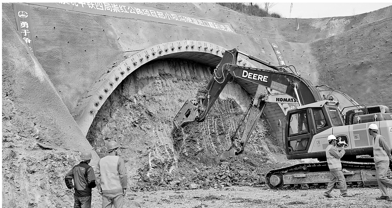
图为崇红公路小坝沟隧道开工现场。
