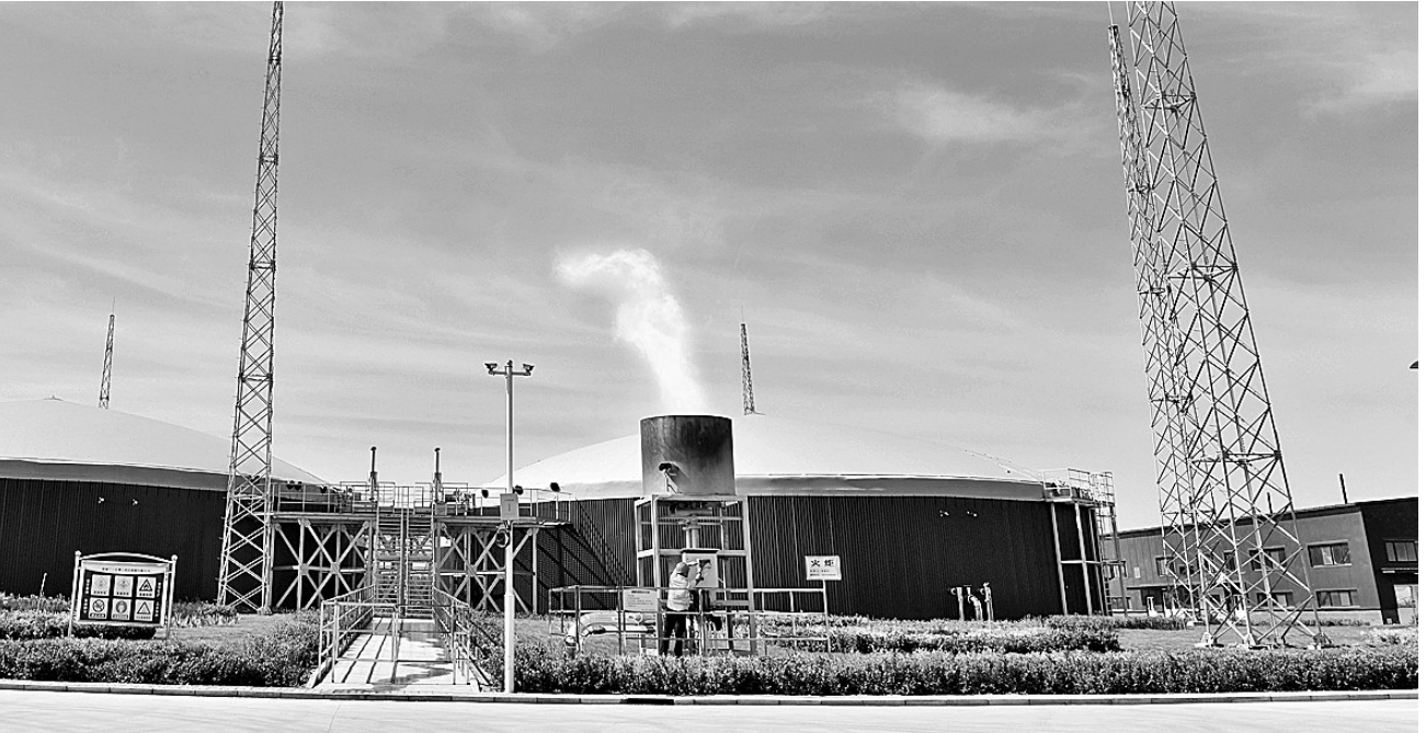
近日,定州市生物天然气生产项目进行生产测试。该项目由国家级高新技术企业北京四方力欧集团投资建设,主要以畜禽粪污和农作物秸秆为原料,采用国际领先的混合发酵技术生产沼气,通过对沼气提纯净化,生产生物天然气。该项目年可处理粪污18万吨、消化秸秆5万亩,年可实现产值3800余万元。白永民摄
