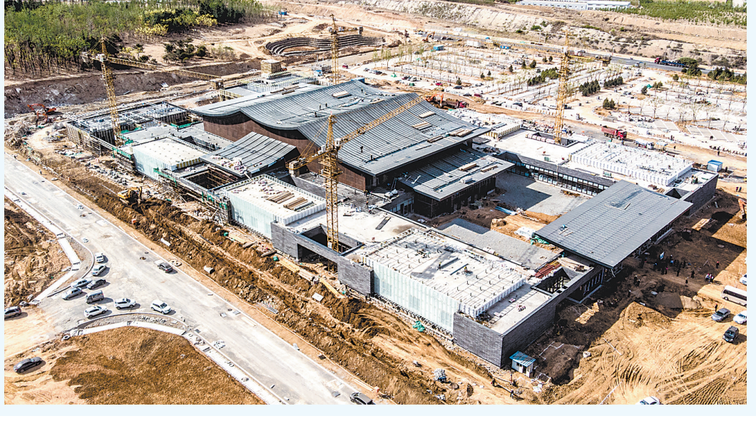
5月3日,河北省第二届园博会主场馆外装施工基本完成。河北省第二届园博会会址位于秦皇岛经济开发区栖云山东麓,主场馆建筑面积16000平方米。目前,内部装修正在紧张进行,整个主场馆工程预计5月底完工。 记者 赵杰 通讯员 崔炜摄
