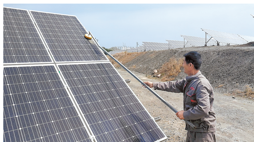
在隆化县韩麻营镇,工作人员正在对官地山尾矿库上建成的光伏电站发电板进行除尘作业。 记者 尉迟国利摄
