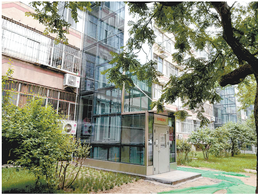
近日拍摄的位于省会五十四所宿舍内的外挂电梯。
