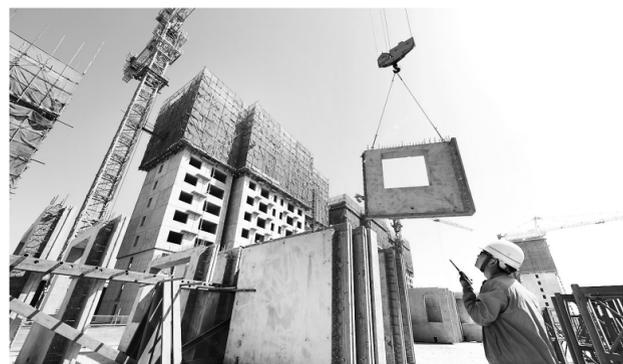
施工人员正在指挥吊装外墙板预制件。崔炜摄
