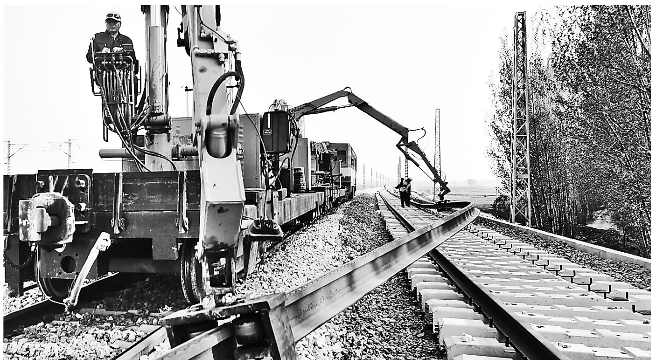
日前,筑路工人在唐曹铁路铺设铁轨。
