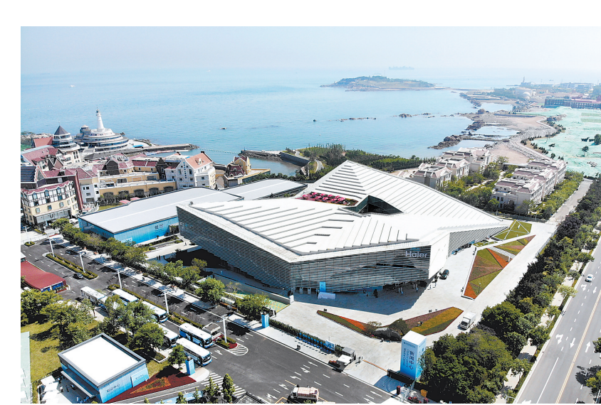
这是位于青岛市崂山区东海路上的上海合作组织青岛峰会新闻中心(6月3日无人机拍摄)。
