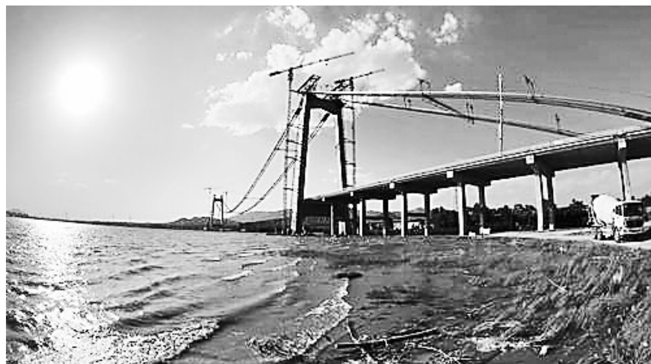
连日来,怀来官厅水库大桥正在紧张有序施工。该大桥2015年10月开工,全桥设计总长1988米,桥主塔高107.8米,桥宽33.6米,采用双向四车道城市主干道标准建设。大桥设计为双塔单跨悬索桥,主桥720米一跨过湖,连接北京延庆和怀来。
