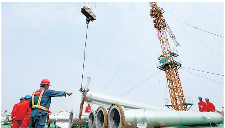
6月4日,雄安新区雄县相庄村,1000千伏特高压定河交流输电线路施工现场。谷玉龙摄
