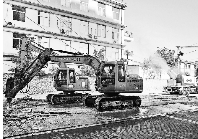
6月1日,施工人员对原有路面进行破除,为下一步路面翻新做准备。日前,路南启动了背街小巷综合整治行动,和泓西路、新华道辅街等10条街巷已进场施工。其中和泓西路、新华道辅街两条断头路打通后,将被打造成样板街区。 通讯员 邢丹妮 记者 刘禹彤摄
