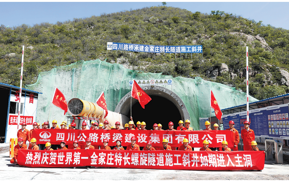
6月15日,位于赤城县的延崇高速金家庄特长螺旋隧道施工斜井井口,施工人员庆祝斜井如期进入主洞施工阶段,这标志着工程建设将进入加速期。延崇高速公路为2022年北京冬奥会重大交通保障项目,金家庄特长螺旋隧道是其中重要控制性工程。 记者 耿辉 通讯员 武殿森摄
