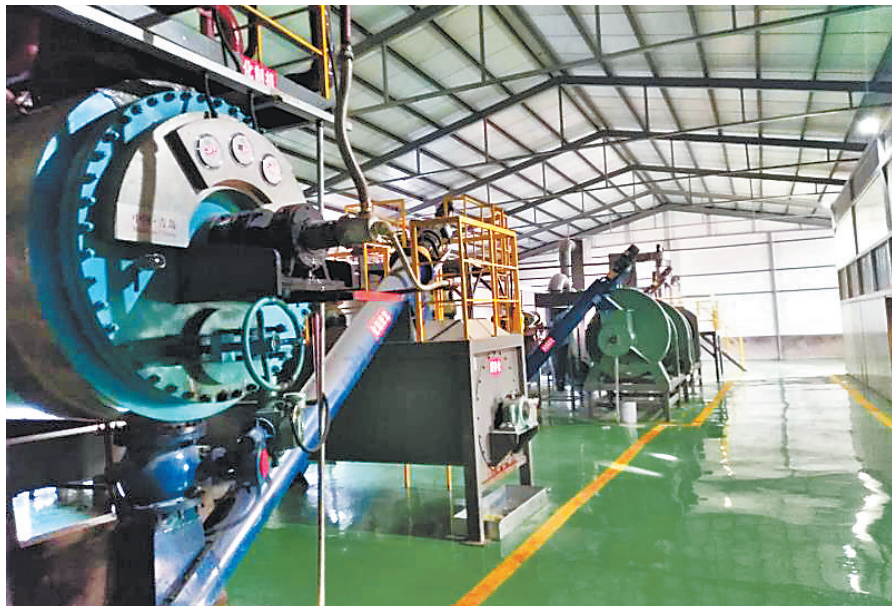
灵寿县达昌病死畜禽集中无害化处理厂生产车间。
