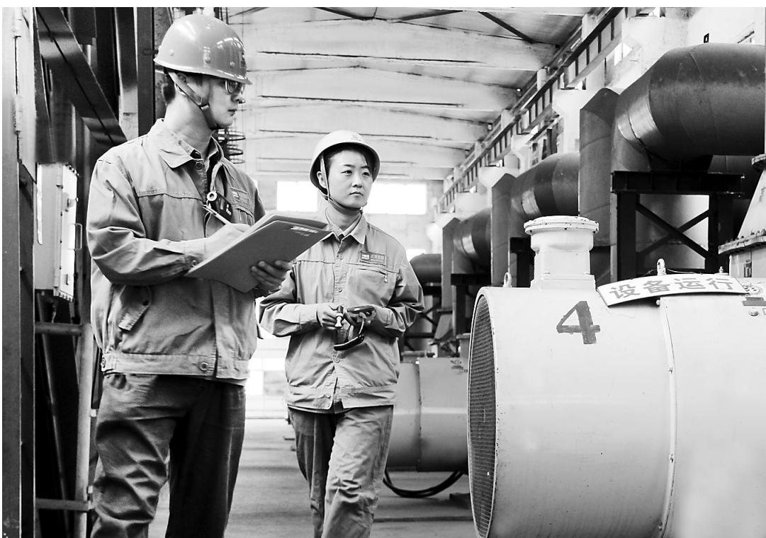
今年6月是第17个全国安全生产月。河钢宣钢围绕“生命至上、安全发展”这一主题,重点对煤气、电气、危险化学品等开展专项检查活动,发现问题及时整改,确保安全生产零隐患。图为设备能源部燃气作业区职工在对煤气系统进行点检。通讯员 牛晓博 记者 刘雅静摄
