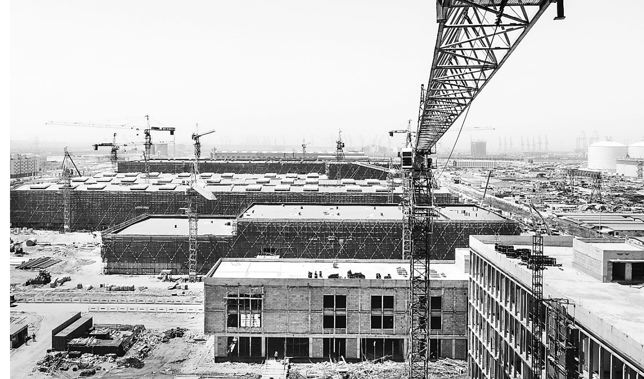
5月30日,位于曹妃甸钢铁电力园的中冶新材料项目厂区建设初具规模。中冶新材料项目是目前国内在建的最大高镍三元前驱体和全球最大的高纯氧化钕研发及生产基地。以该项目为平台组建的高镍三元材料工程研究中心和铝钎合金大规模产业化装备制造工程研究中心,将引领动力电池和新能源汽车产业发展。
