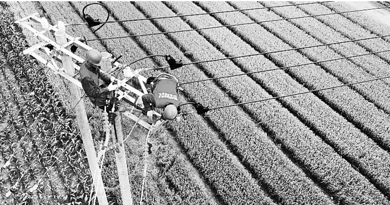
近日,乐亭县供电公司共产党员服务队队员张伟、李爱唐站在距离地面约10米高的横担上更换绝缘线。该公司共产党员服务队在高温条件下连续野外作业,检查供电线路、维修用电设施,确保农田用电无虞。 记者 刘禹彤 通讯员 李建洲摄
