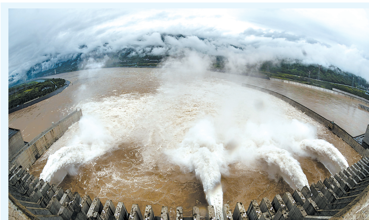
7月5日,江水通过三峡大坝泄洪深孔下泄。当日8时,三峡水库入库流量达到5.1万立方米每秒,出库流量4万立方米每秒。长江2018年第1号洪水在长江上游形成,目前正在通过三峡库区。18时,中央气象台发布渍涝风险气象预报。受降雨影响,预计7月5日20时至7月6日20时,江苏北部和南部、安徽南部、江西东北部、湖北西南部、湖南西北部、重庆东南部、贵州东北部等地发生渍涝的风险等级较高,易形成城市内涝和农田渍害,需加强防范。新华社发
