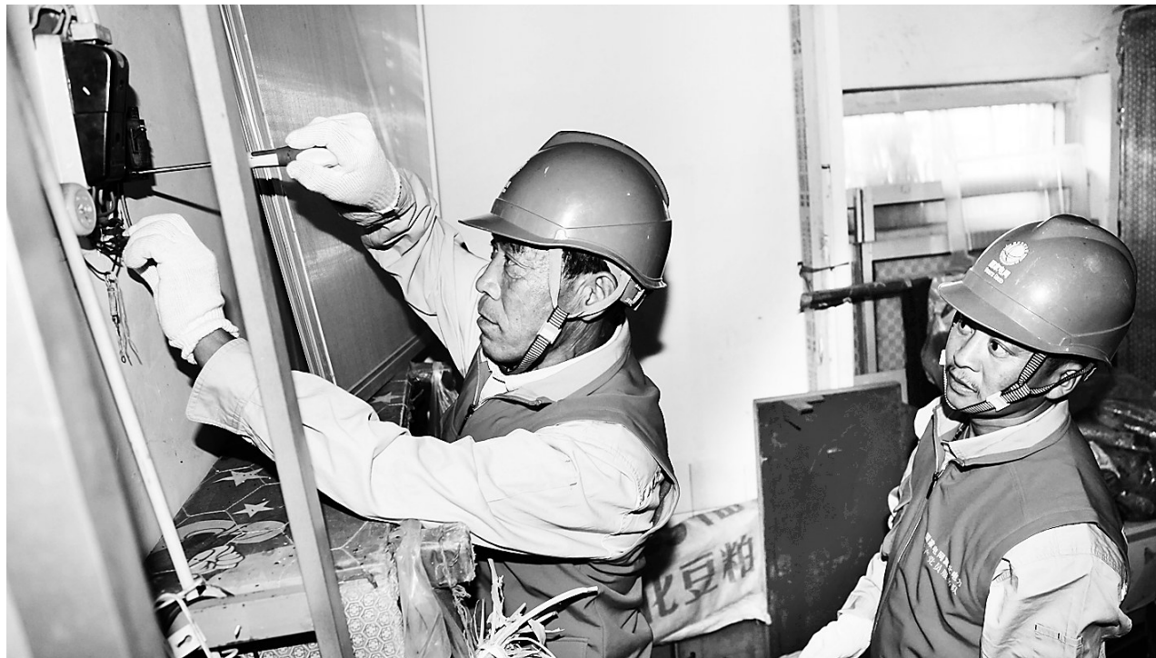
近日,承德供电公司员工为客户义务安装家用漏电保护器。为保证居民清凉度夏,承德供电公司组织开展电网建设、隐患排查、应急抢修、优质服务等多项工作,做好重要时段、重点区域的负荷变化研判,确保全市电力供应安全有序。 通讯员 孙艳宇 记者 陈宝云摄
