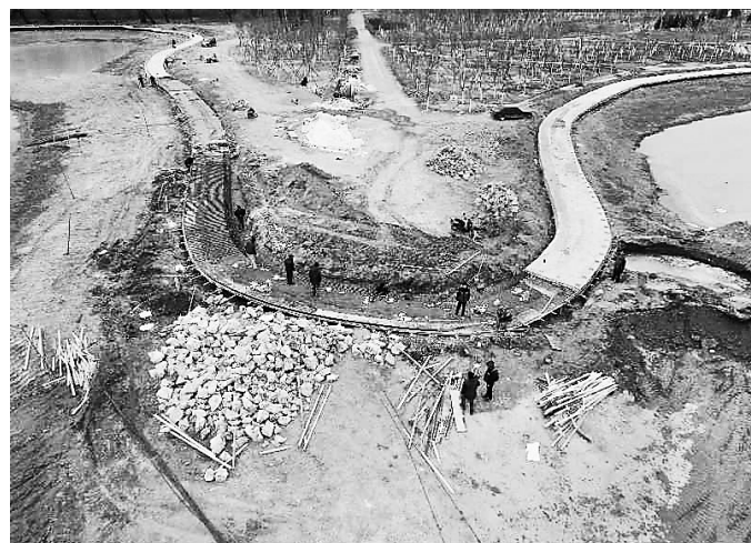
怀来官厅水库湿地公园项目一期建设总投资12亿元,湿地修复面积6万余亩。图为怀来官厅水库湿地公园项目建设现场。王如楠摄
