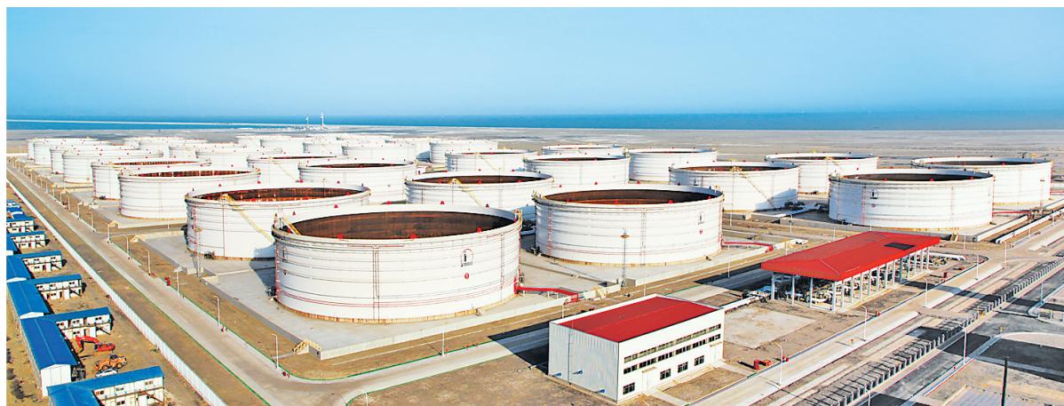
中石化石油储备库全景。
