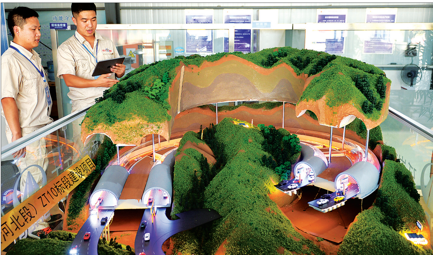
下图:施工人员正在延崇高速金家庄特长螺旋隧道模型旁规划施工方案。
