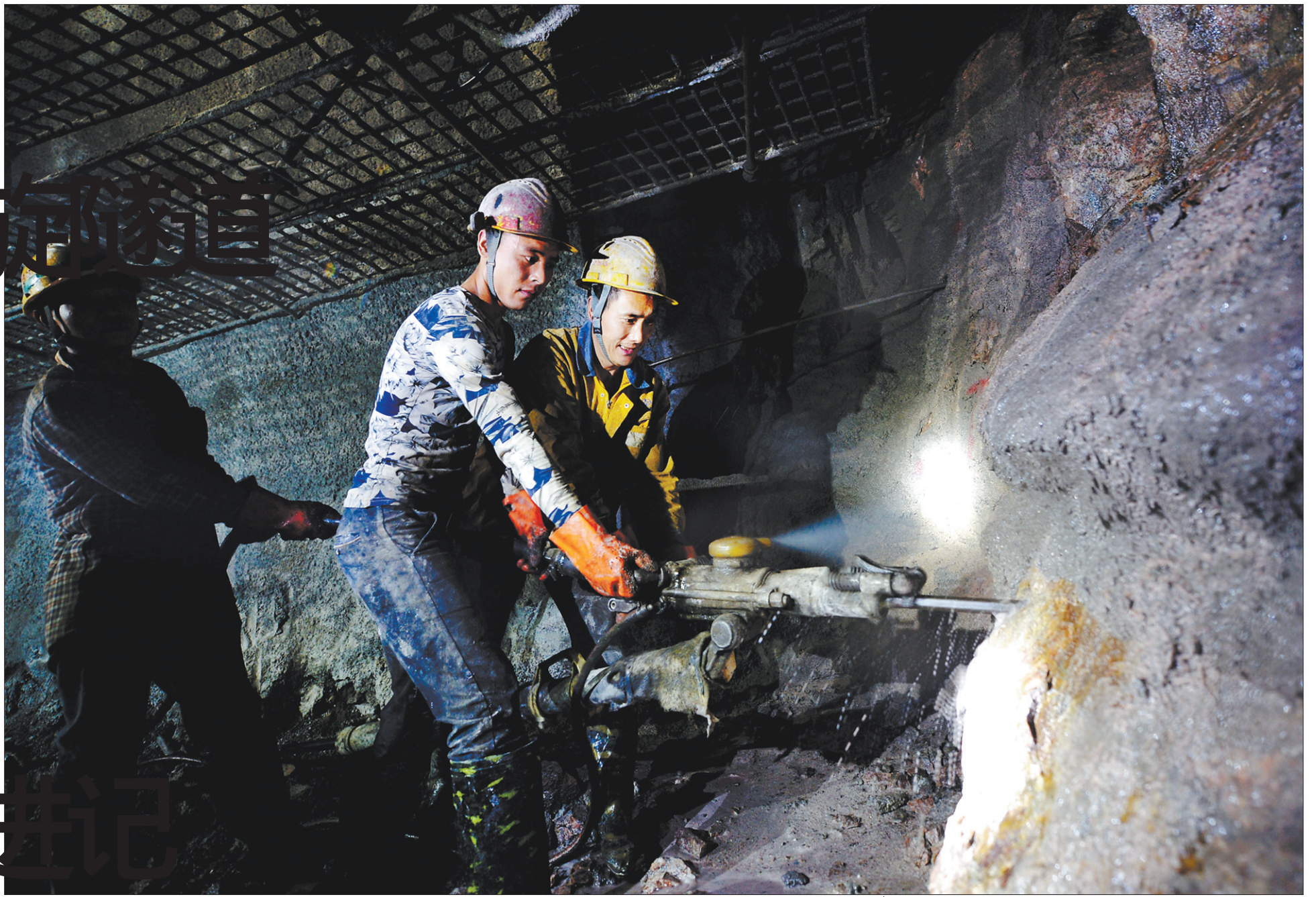
上图:在1500多米的隧道深处,工人们手握钻机掘进作业。
