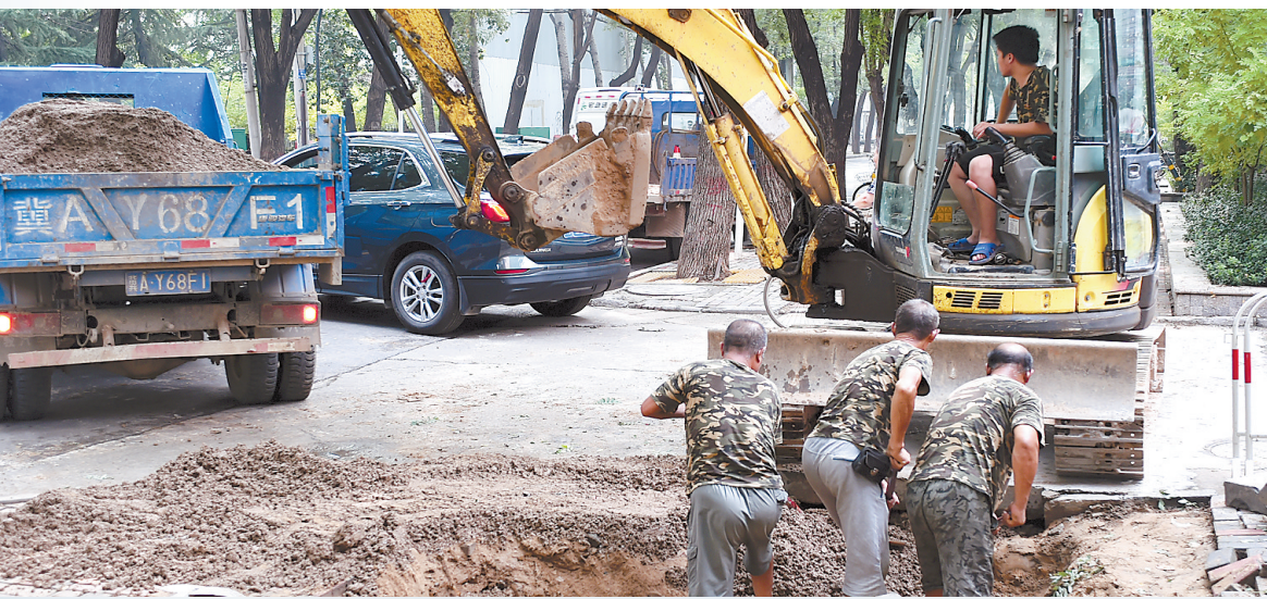
8月13日,石家庄市道桥管理处工作人员正在槐北路抢修塌陷路面。受强降雨影响,省会槐北路两处出现路面塌陷,该处迅速组织工作人员抢修塌陷路面,确保市民出行。 记者 田瑞夫摄
