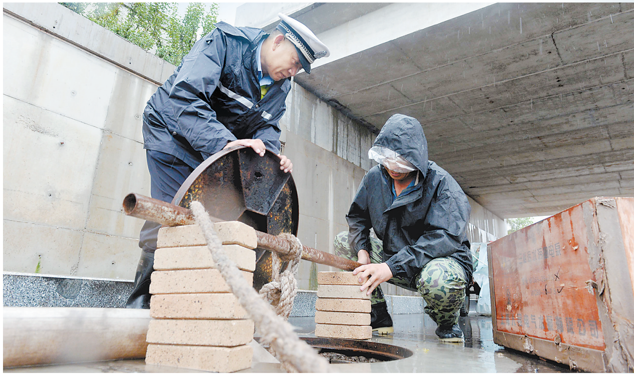
排水 8月14日,唐山市排水管理处工作人员在唐山市第八交警大队民警协助下冒雨在西山地道桥进行排水作业。当日,唐山市排水部门及时启动市区内11座排水泵站,并在龙泽路裕华道口、丰润燕山路、开平志方购物等3处易积水地点增设1台大型移动泵车和2台移动泵,加快排除积水,保障市民出行。 记者 张昊 王育民摄
