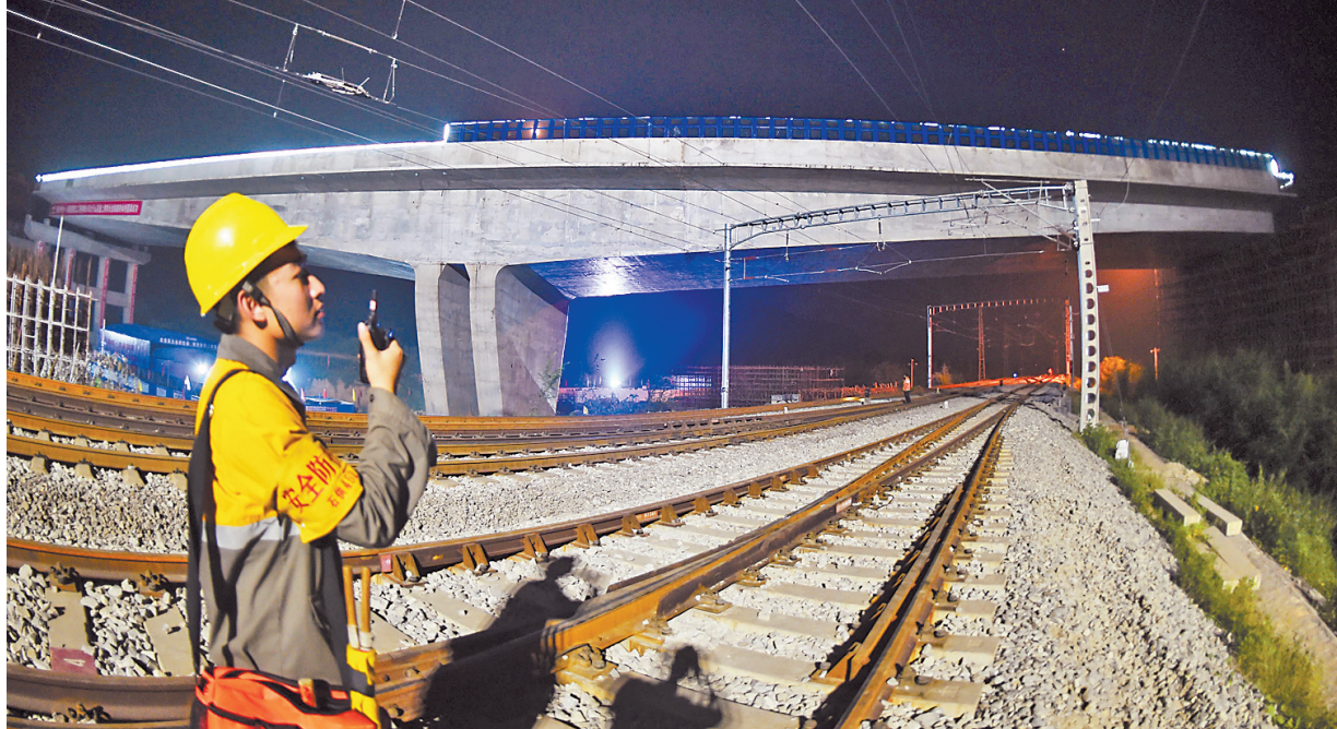
8月27日21时18分,由中铁十八局承建的太行山高速邯郸南洛河特大桥跨邯长铁路转体桥,在两台自动连续千斤顶的牵引下,成功转体63.5度,实现完美转身。南洛河特大桥转体桥是太行山高速第一座采用转体施工跨越铁路的桥梁,该工法能够最大限度减少对铁路运营的干扰,安全性高。
