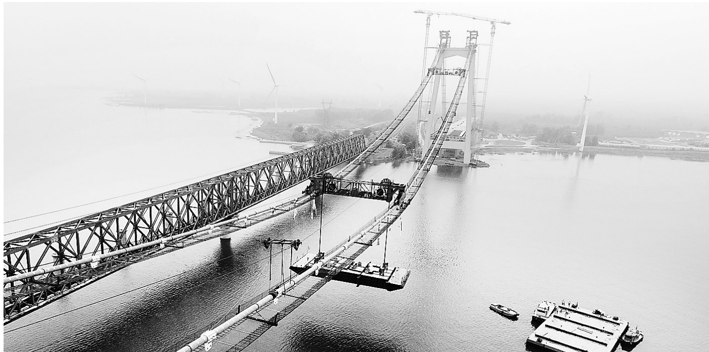
近日,怀来官厅水库悬索公路桥首节段加劲梁浮运起吊作业圆满成功。据介绍,加劲梁作为悬索桥重要承载结构,是整座大桥的核心。首节段加劲梁起吊的顺利完成,为下一步加劲梁的桥上拼接和桥面铺装等系列施工作业提供了保证,为整座大桥的合龙迈出了关键一步。这是首节段加劲梁起吊现场。
