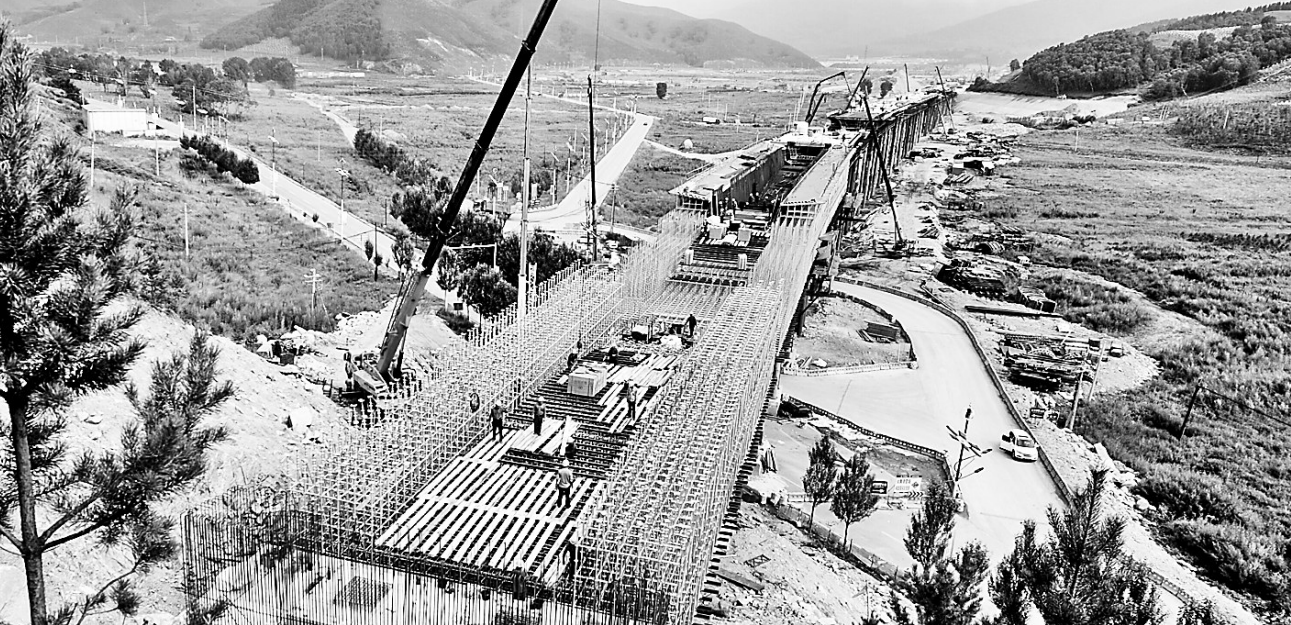
京张高铁崇礼支线太子城特大桥由中铁四局承建,位于太子城车站西北方向,设计为双线大桥,线间距4.6米,全长801.74米,是崇礼区最长铁路桥,目前正在进行现浇梁混凝土浇筑工作,整体工程预计10月底完工。这是近日京张高铁崇礼支线太子城特大桥繁忙的施工现场。
